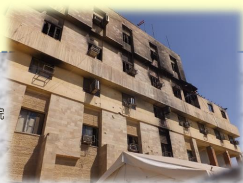
モスル総合病院 3・4階は 使用不能
