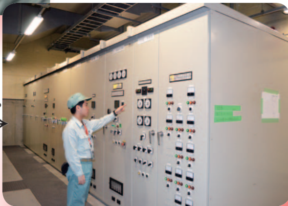
非常用発電機
