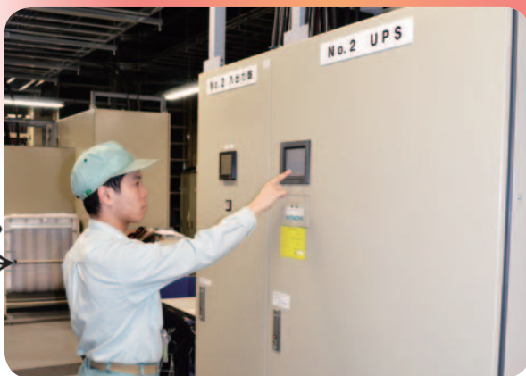
無停電電源装置（UPS）
