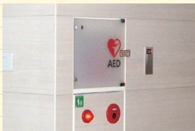
日赤医療センターの建物内にあるAED
