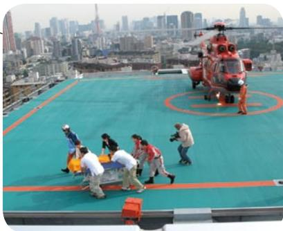
衝撃荷重 10 トンまで耐えるアルミデッキ式のヘリポートを屋上に設置。大規模災害の発生時などに、ヘリコプターを使った患者さんの受け入れに対応します。
