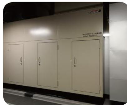
灯油から電力を生み出すことができる発電機を完備。災害などで商用電力と都市ガスの供給が断たれても、灯油による発電だけで、3日分の電力を確保することができます。
