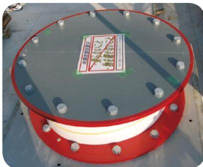
地下部分に設置された積層ゴムによる免震装置
